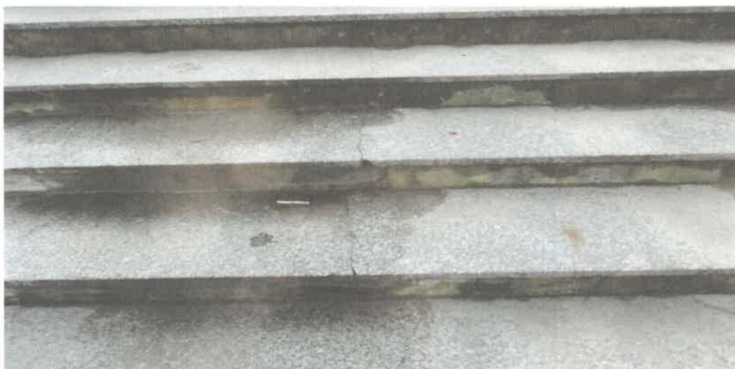
Fot. 5 Widok popękanych płyt granitowych stopni.
