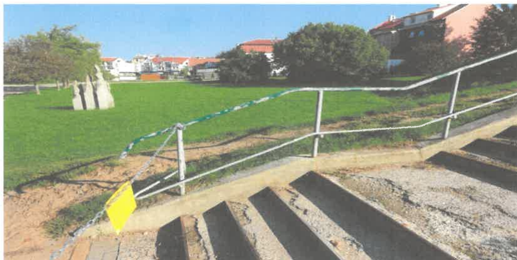
Fot. 9 Widoczne łuszczenie betonu. Balustrady do demontażu.
