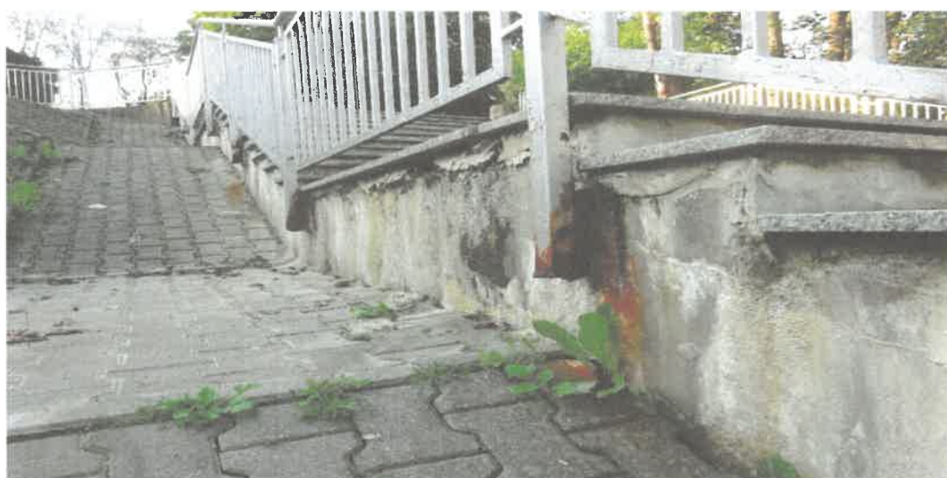
Fot. 4 Widok łuszczącego betonu policzków i korozji balustrad stalowych.
